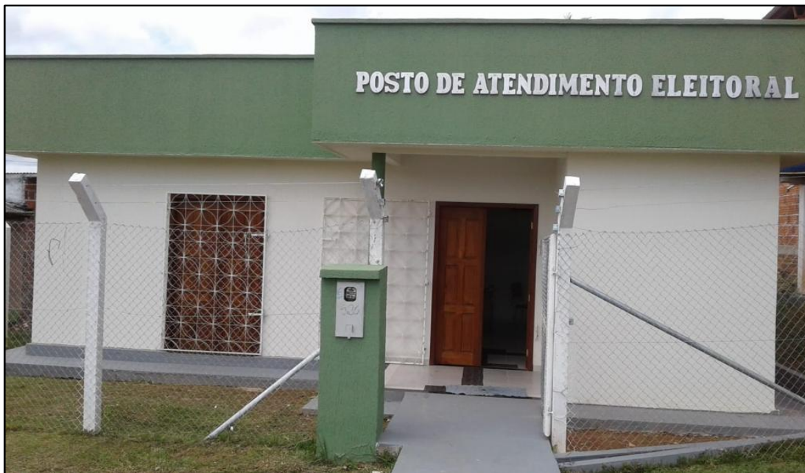
Foto 14 - Localizado na Rua Romildo Magalhaes, s/n, Jordão-Acre
