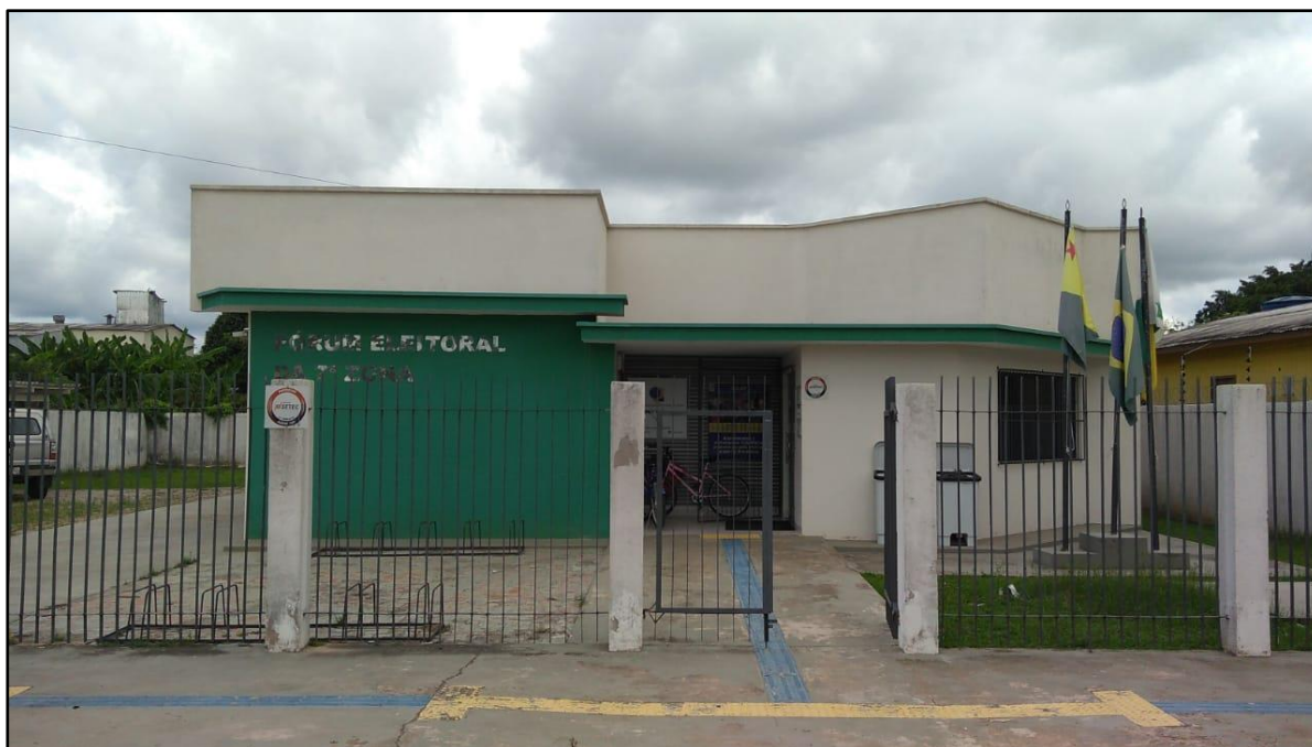
Foto 16 - Localizado na Rua Cornélio Oliveira de Lima, s/n - Centro, Feijó-Acre
