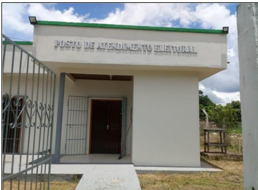
Foto 4 - Localizado na Rodovia AC 10, Km 56, s/n - Livramento, Porto Acre-Acre
