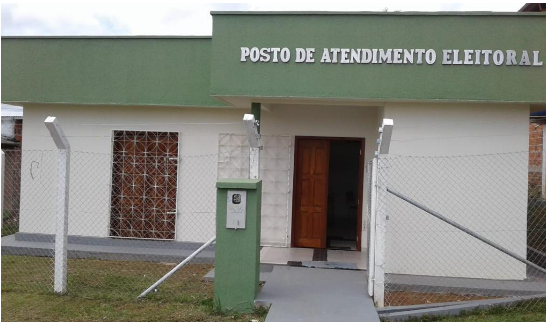
Foto 14 - Localizado na Rua Romildo Magalhaes, s/n, Jordão-Acre
