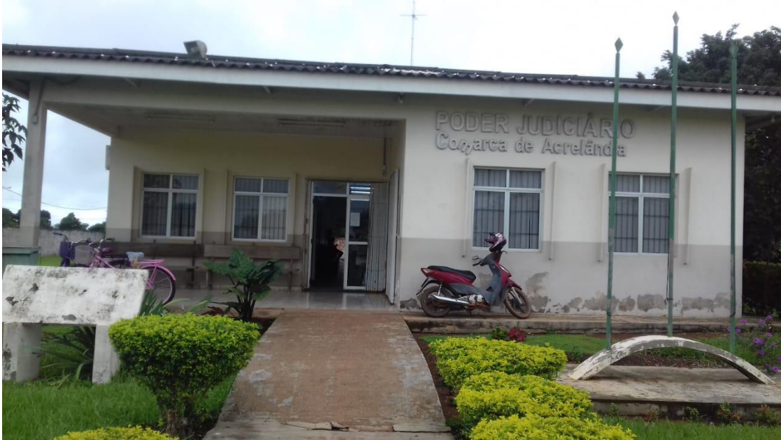
Foto 19 - Localizado na Avenida Governador Edmundo Pinto, 581, Centro Prédio do Fórum Dr. João Oliveira de Paiva, Acrelândia-Acre
