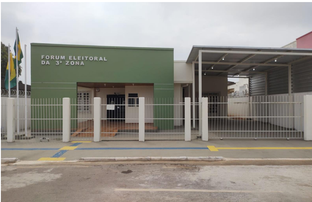
Foto 6 - Localizado na Rua Cunha Vasconcelos, 659 - Centro, Sena Madureira-Acre
